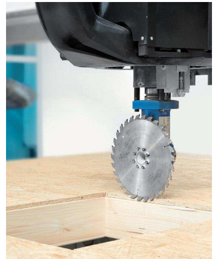
Realización de las aberturas de ventanas
