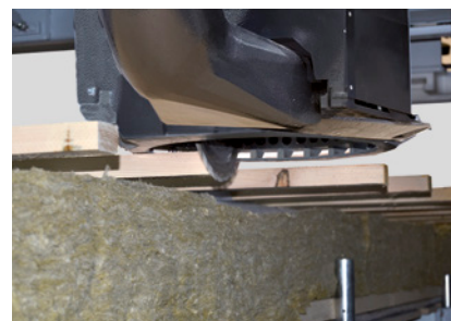
Formatowanie łąt dachowych
