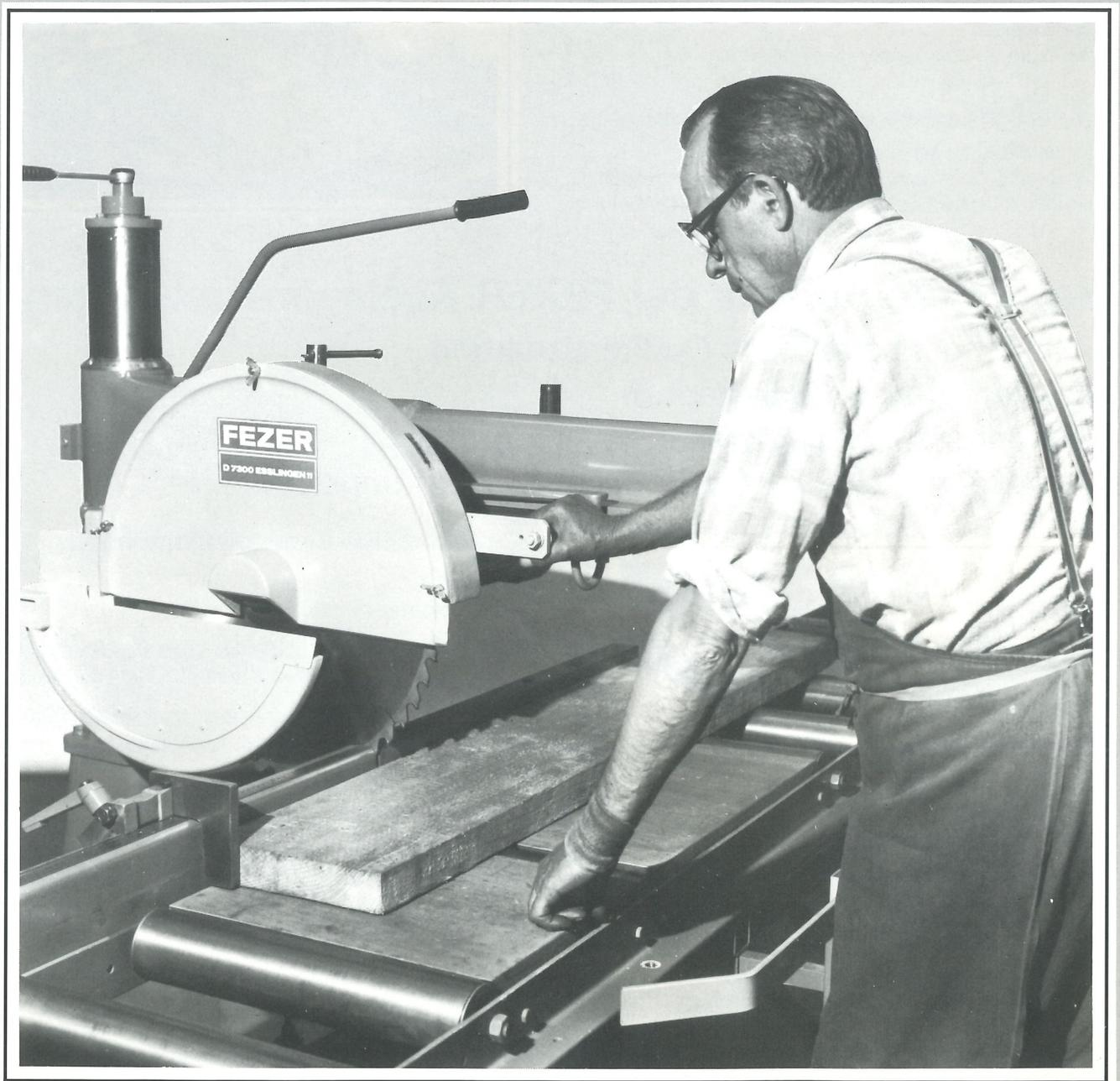
Für Abläng- und Winkelschnitte, Kervenfräsungen, Ausplattungen an Brettern, Bohlen, Balken u. a., Holzwerkstücken, in Spezialausführung auch für Alu und Stein
