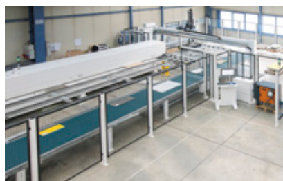
Ausrüstung für CE Konformität: Schutzgitter entlang der gesamten Rückführstrecke
