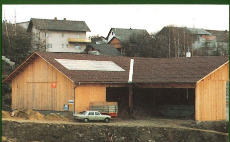
Bäuerliche Heizgemeinschaft A-4794 Kopfing 1500 kW
