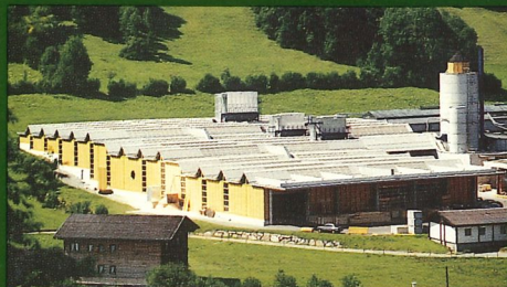
Kaufmann, Holzbauwerk A-6870 Reuthe 1900 kW
