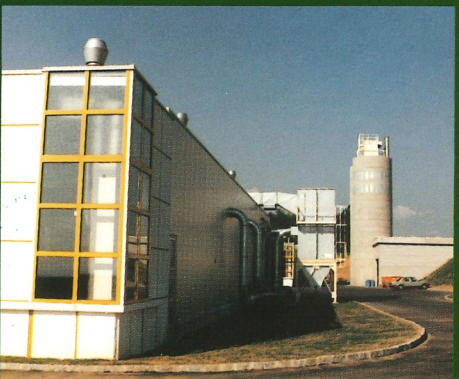
Josko Fenster- + Türenfabrik A-4794 Kopfing 1400 kW 700 kW
