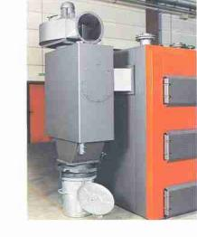
Der integrierte Staubabscheider mit Saugzug und leicht wechselbarer Staubtonne.
