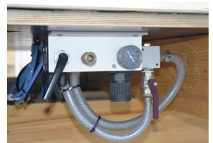
Kit pneumatique pour l'alimentation centrale en air et la commande des poutres de serrage C-PowerTec
