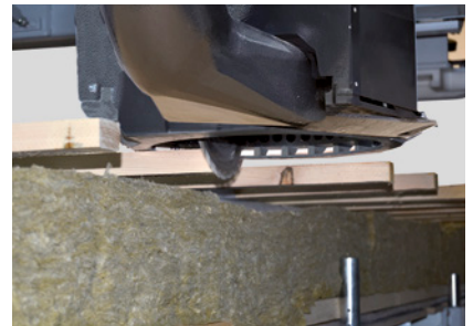
Formatieren der Dachlattung
