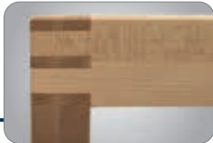
Fingerverzinkung in Hinterzange und Beiladerücken
