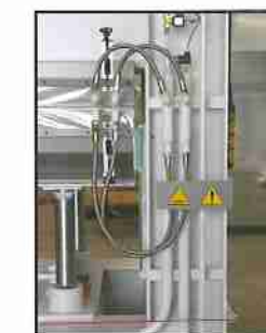
Impianto di riscaldamento Heating system Heizkreisanschlüsse
